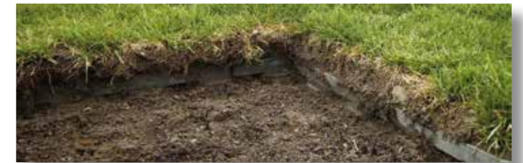
Die TTE®-Bewehrung unter dem Rasen
