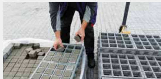
Сначала на строительной площадке вставьте брусчатку TTE®, затем уложите элементы. Перемещайте поддоны при помощи тележки с грузоподъемным устройством.
