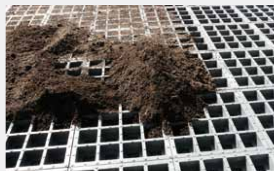
Для озеленения TTE® Multi-Drain PLUS заполняется рыхлой смесью верхнего слоя почвы, песка и мелкого гравия.
